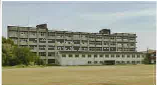
▲解体設計の予算が計上された旧毛呂山高校跡地
