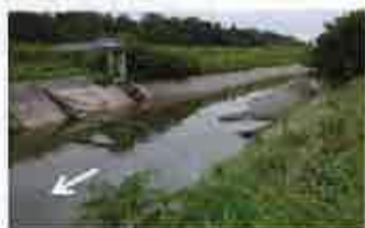
真栄堰 倒伏状態
