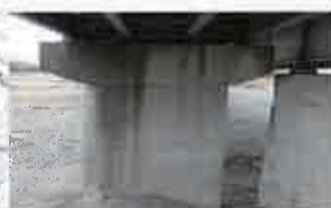
耐震(橋脚補強、ひび割れ補修)
