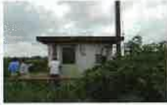
大塚地下水機場
