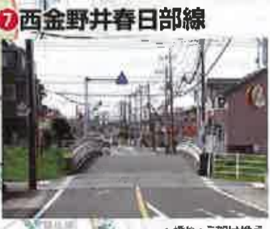
▲橋りょう架け換え
