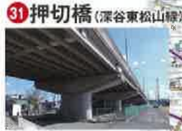
耐震(橋脚補強)
