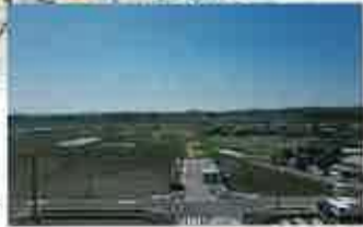
道路改良工事業 (L=2,440m、 W=6.5(15.0)m)
