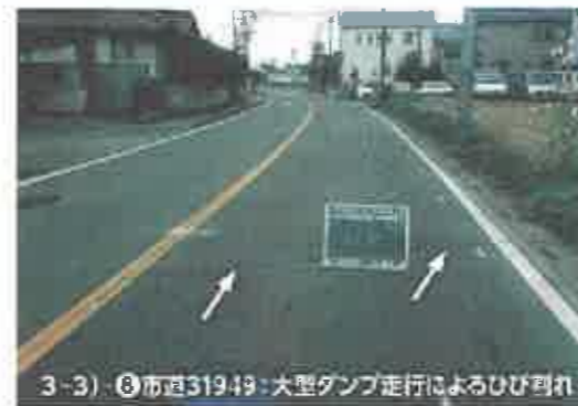
3-3)-⑧市道31949：大型ダンプ走行によるひび割れ
