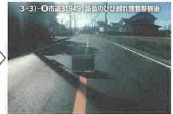
3-3)-⑧市道31949：路面のひび割れ舗装整備後
