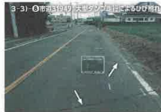
3-3)-⑧市道31949：大型ダンプ走行によるひび割れ
