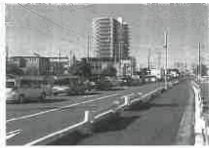
③北上尾の踏切立体交差化を再始動
