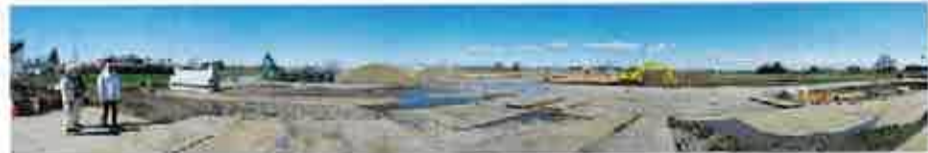
13.8haの広大な面積を有する小林調節池。洪水調節量は毎秒14.1m 3 、調節容量は68万m 3 を想定しています。
