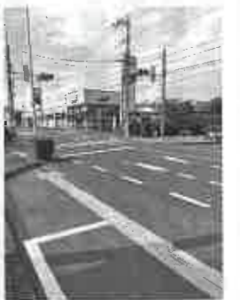
⑦西上尾第1団地前の冠水対策 雨水マスを下流に接続(接続先を複数試行中) ※市と連携
