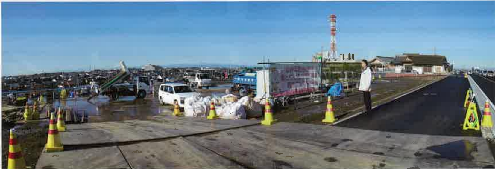
八坂神社の前、県道羽生外野栗橋線沿いに防災拠点施設が建設されます。完成は令和6年度中の予定です。
