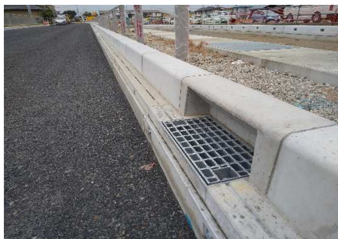
縦断側溝施工
