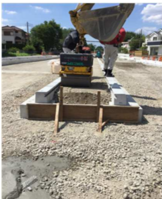
縦断側溝施工
