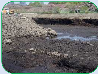
与野中央公園調節池護岸工事
