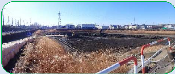
伊奈町第 1 調整池浚渫
