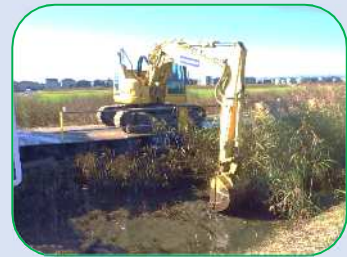
綾瀬川河道掘削
