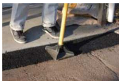
上から転圧します
