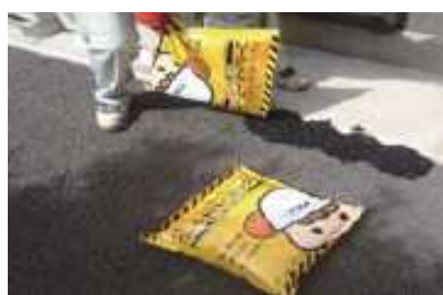
袋から出して敷き均します
