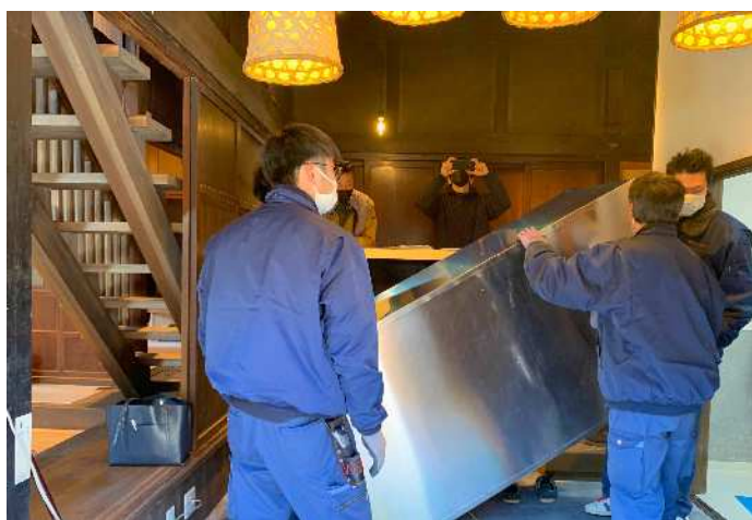
古民家リノベーション・改修の様子
