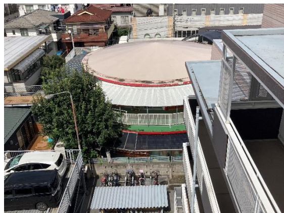
南面側 屋根外観
