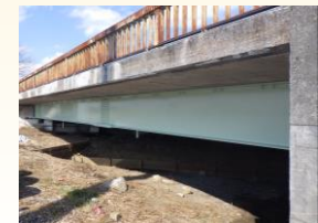
橋りょう修繕
