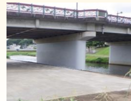
橋りょうの耐震化
