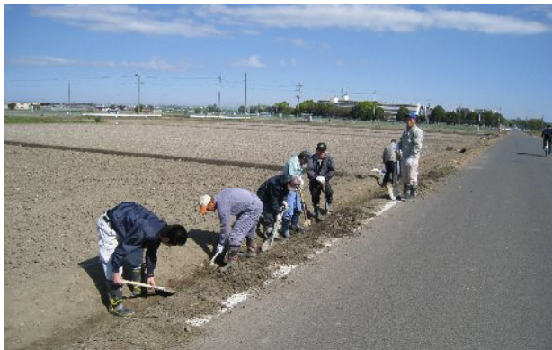
開水路の清掃
