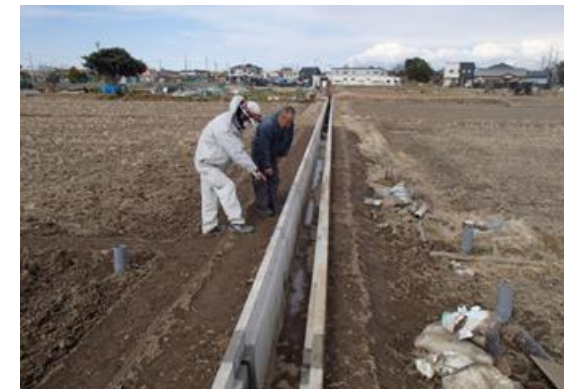
水路の整備 (完成)
