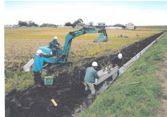
水路の整備 (施工中)
