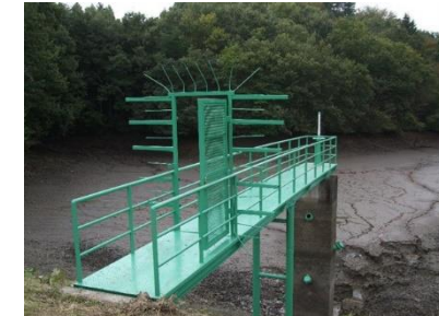
取水施設の補修
