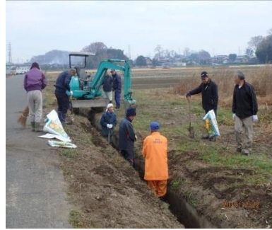
水路の泥上げ
