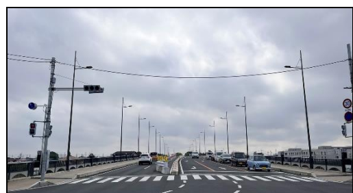
【整備後の状況（吉川橋）】
