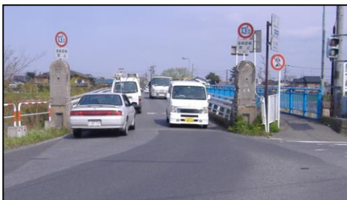
【整備前の状況（旧吉川橋）】
