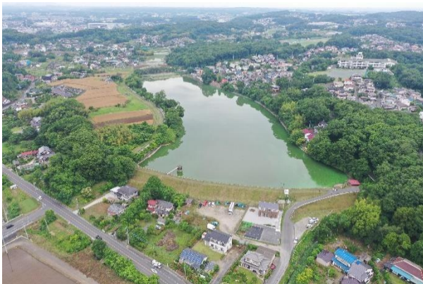
堤体の下流に住宅や道路が近接するため池（大沼（大）・吉見町）
