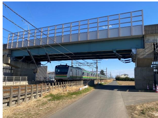
耐震性強化のため橋台を補強（かみはら陸橋 深谷市）
