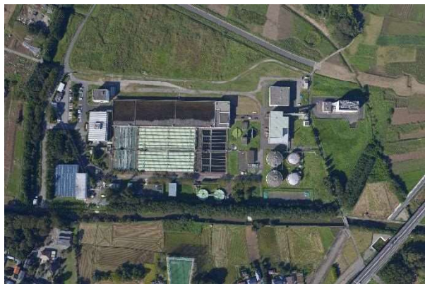
古利根川水循環センター（久喜市）
