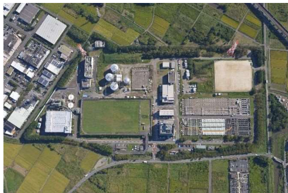
元荒川水循環センター（桶川市）
