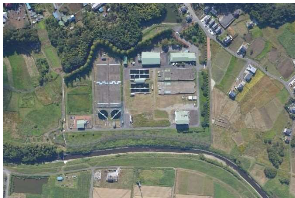
市野川水循環センター（滑川町）
