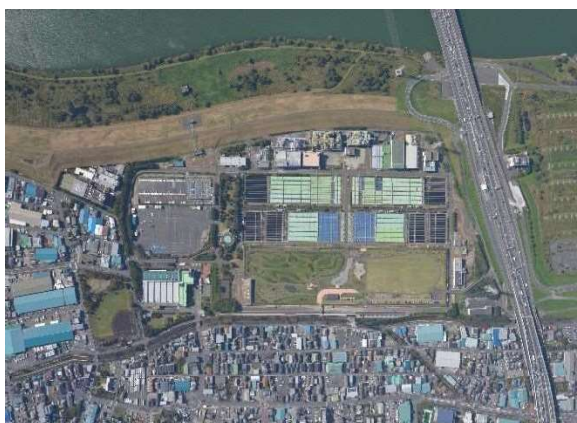
荒川水循環センター（戸田市）
