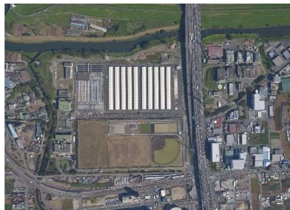
新河岸川水循環センター（和光市）
