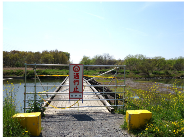
【参考】通行止めの状況(2023 年)
