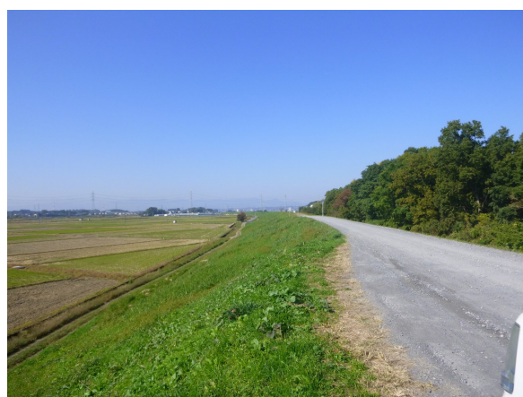
土手の状況 (飯盛川方向)
