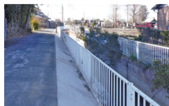
▲整備後（防草コンクリートを施工）
