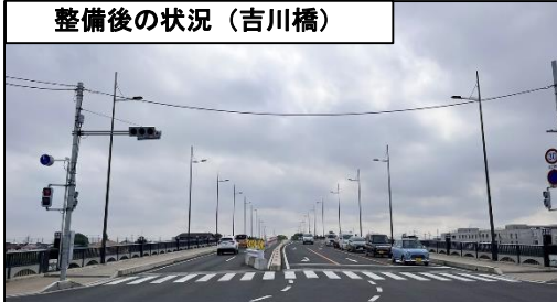
整備後の状況(吉川橋)
