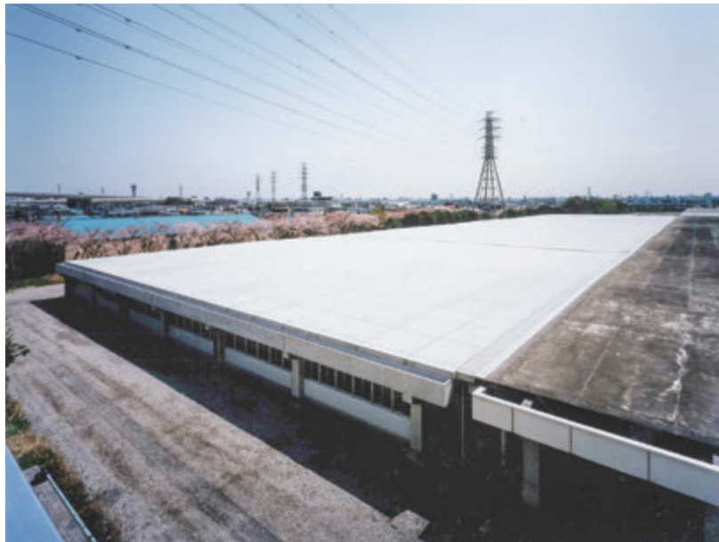
写真 - 1 屋上全景
