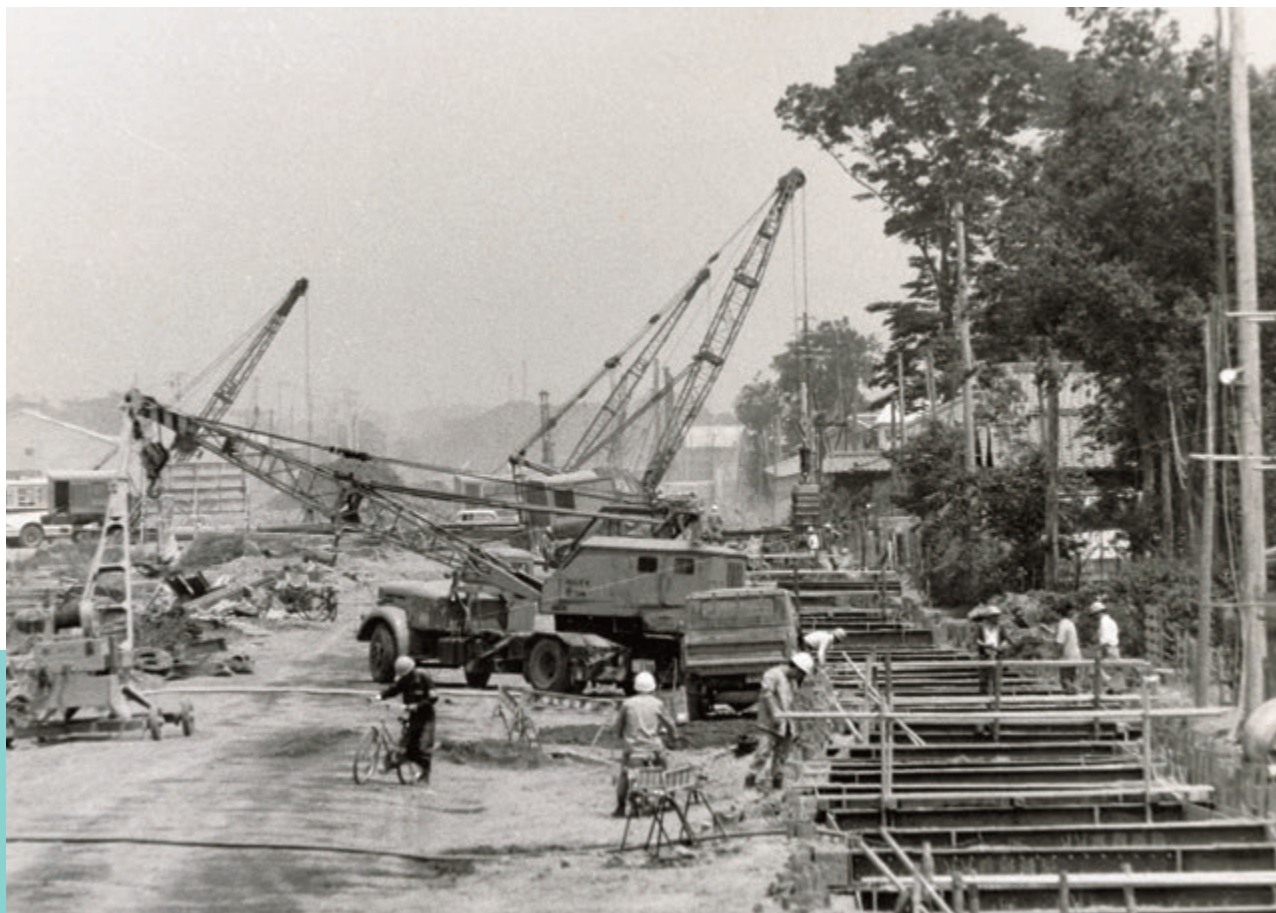
重機による開削工事
