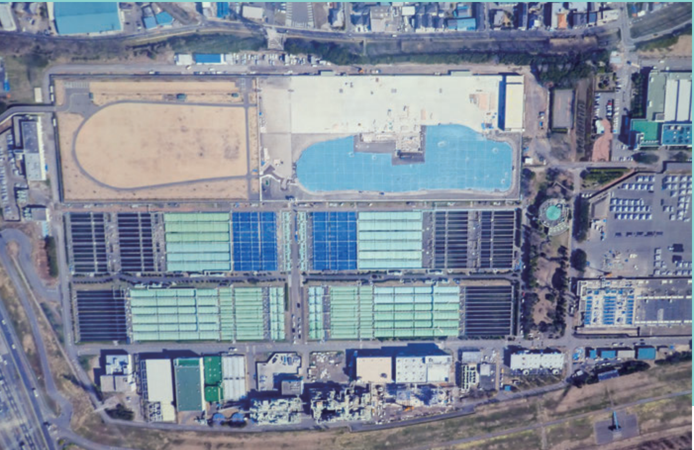
荒川水循環センター全体風景（平成26年3月撮影）
