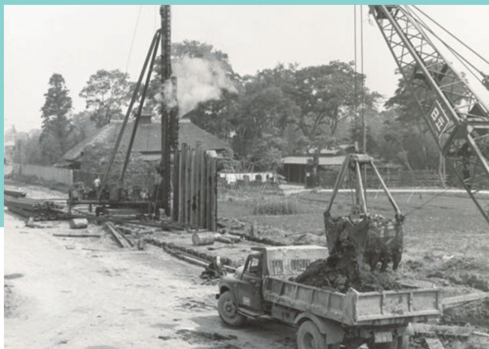
掘削した土砂を排出
