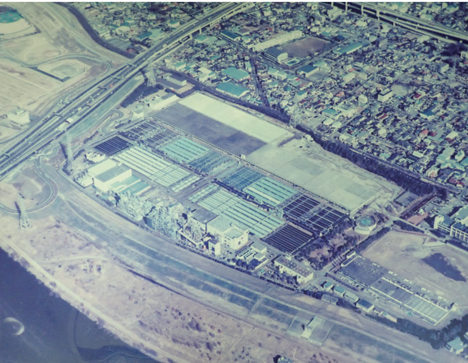
荒川処理センター全体風景（平成16年2月撮影）
