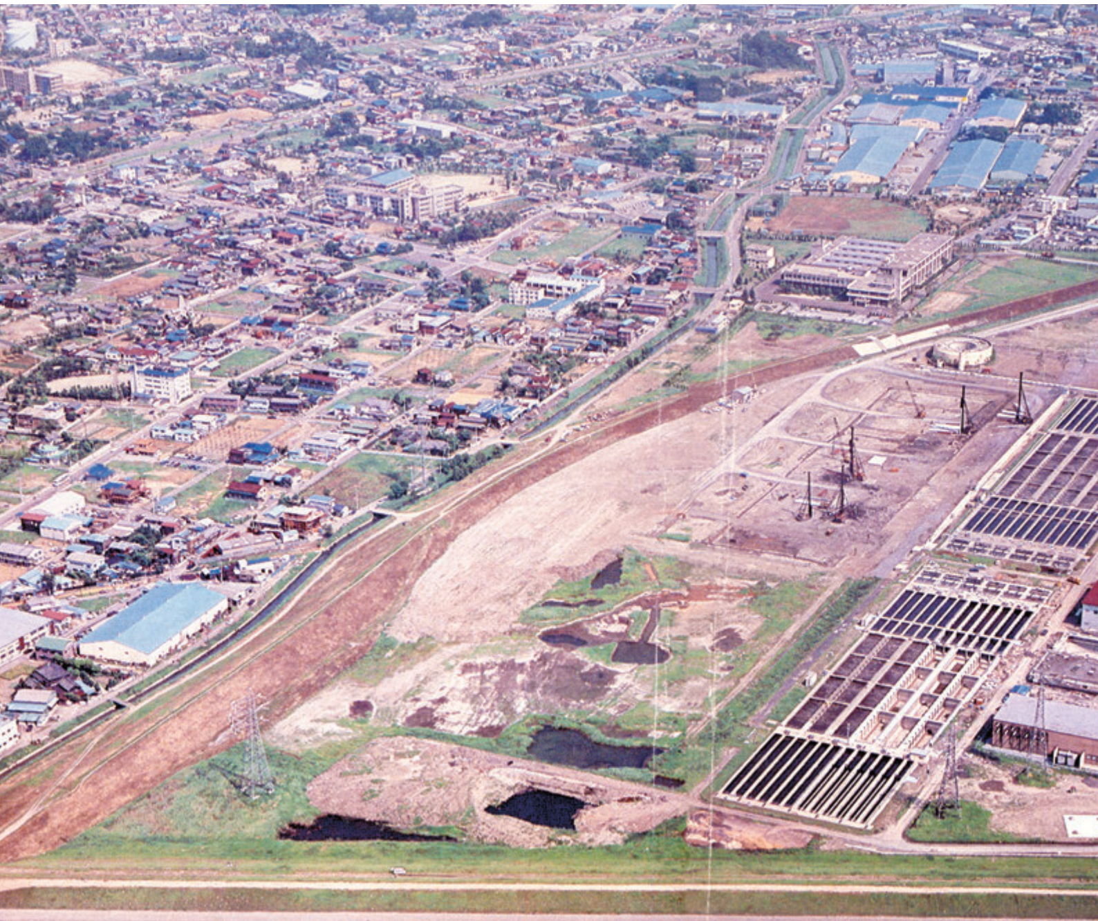
荒川処理センター全体風景（昭和 54 年以前撮影）
