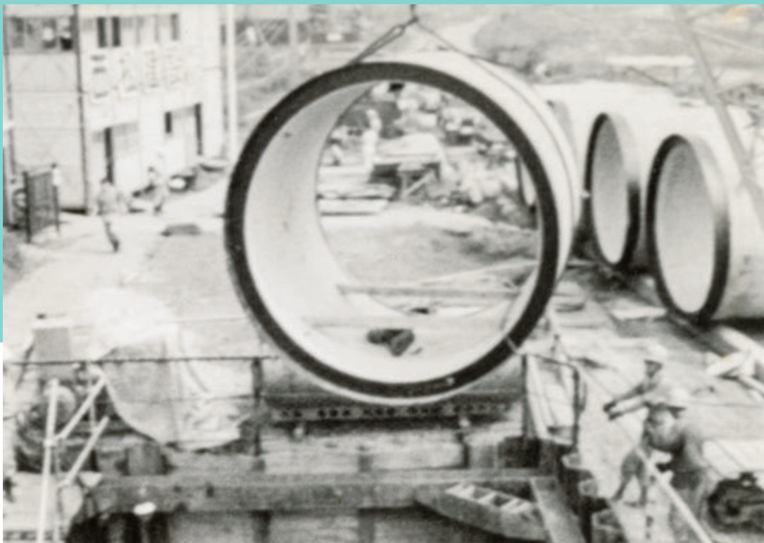
下水道管を吊り下ろす
