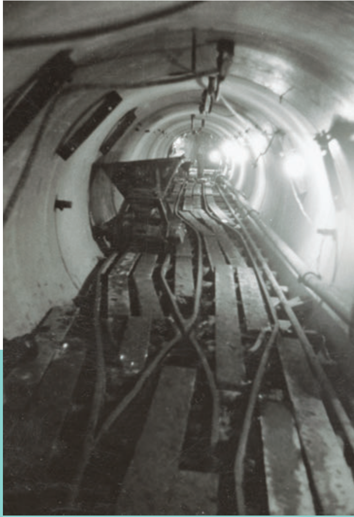
トロッコを使用して土砂搬出
