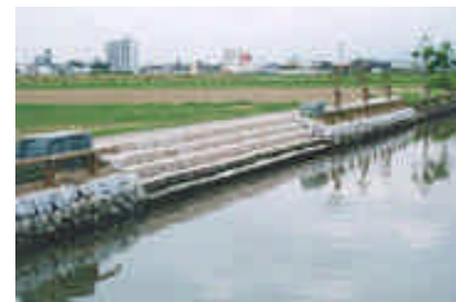
階段護岸の施工事例
