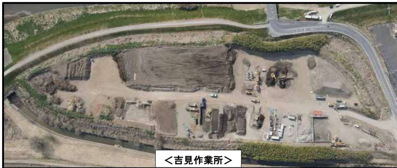
含水率の高い残土で草・葦根等混入有 二筒式トロンメルと吸選機で分別作業を行う。
