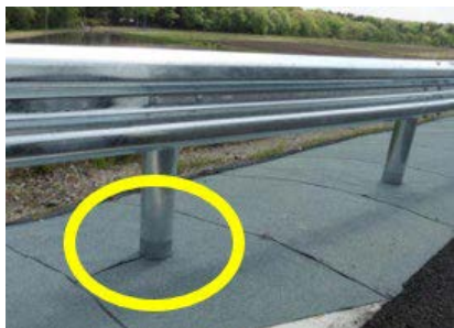
ガードレール支柱地際防食
