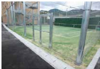
県立高校防球ネット支柱地際防食
