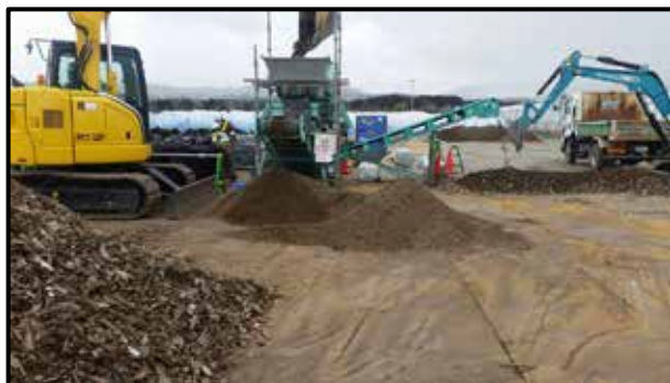
含水率の高い残土で草・葦根等混入有 二筒式トロンメルと吸選機で分別作業を行う。
