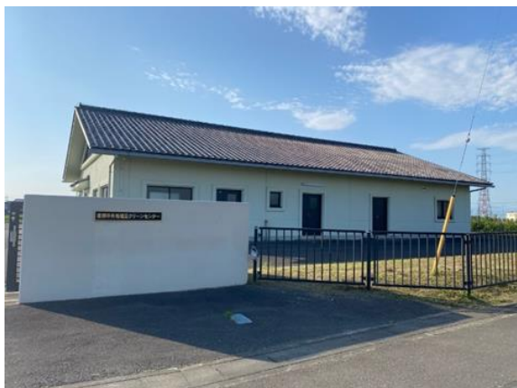
農業集落排水施設
