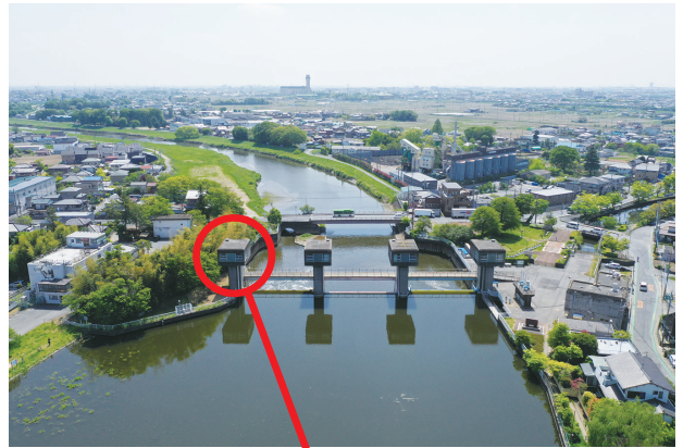
◀土地改良区管理施設（古利根堰）
