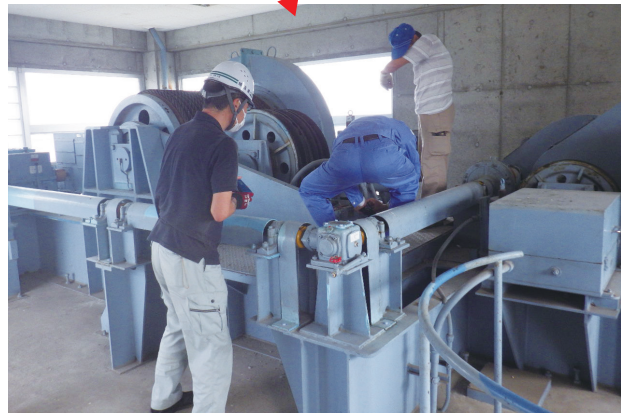
◀古利根堰のゲートの点検をする様子
