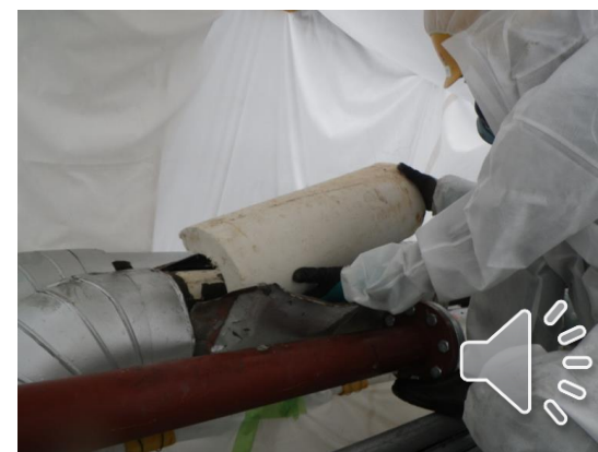
養生内で湿潤化後、手作業で除去
