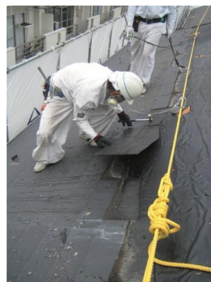
スレートの除去
