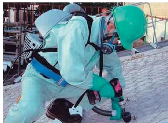
集じん回収（高性能真空掃除機）
