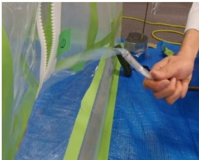
①前室が負圧に保たれていることの確認方法の例 (スモークテスターによる気流の確認)
