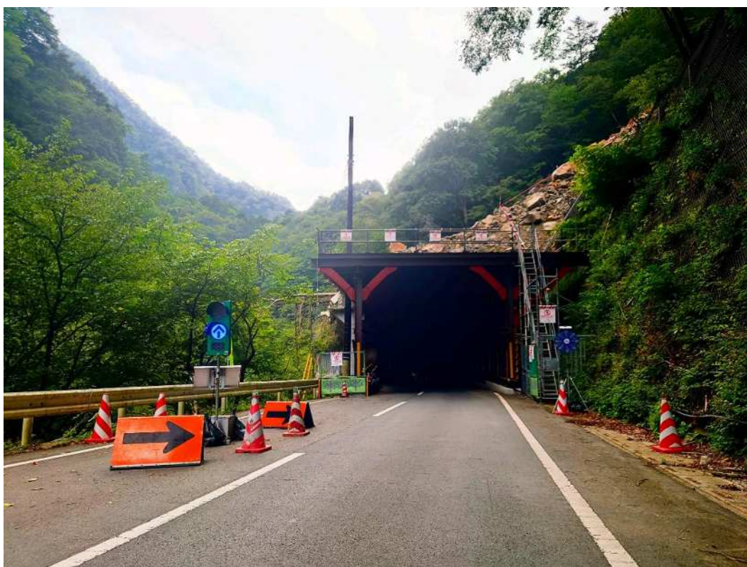
県道中津川三峰口停車場線 応急復旧工事(中津川側 ロックシェッド付近)
