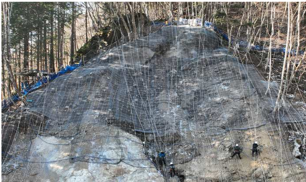
県道中津川三峰口停車場線 応急復旧工事(岩盤崩落部)
