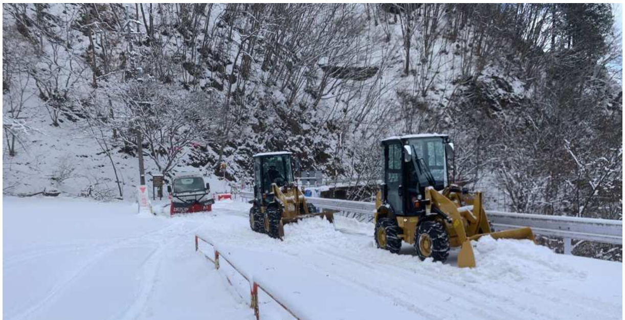
金山志賀坂線 八丁峠 除雪状況
