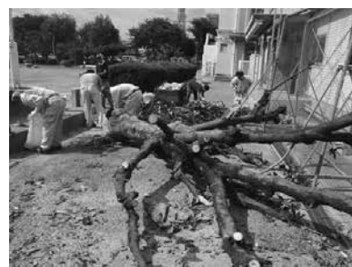
〔倒木処理作業〕 (桶川市立桶川中学校)
