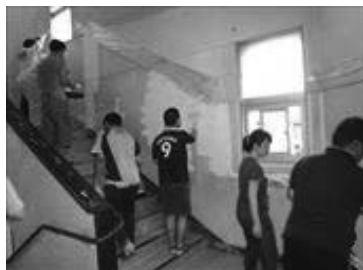
〔昇降口・階段のペンキ塗り〕
