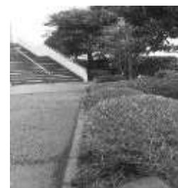
【剪定された植木に囲まれた生徒通路】
