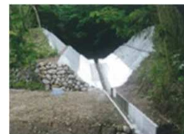
堤体切り下げによるため池の廃止
