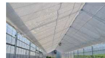
栽培施設への遮光資材整備
