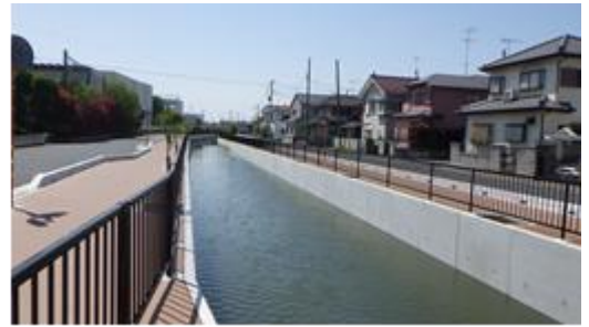
▲ 整備後の酒巻導水路
