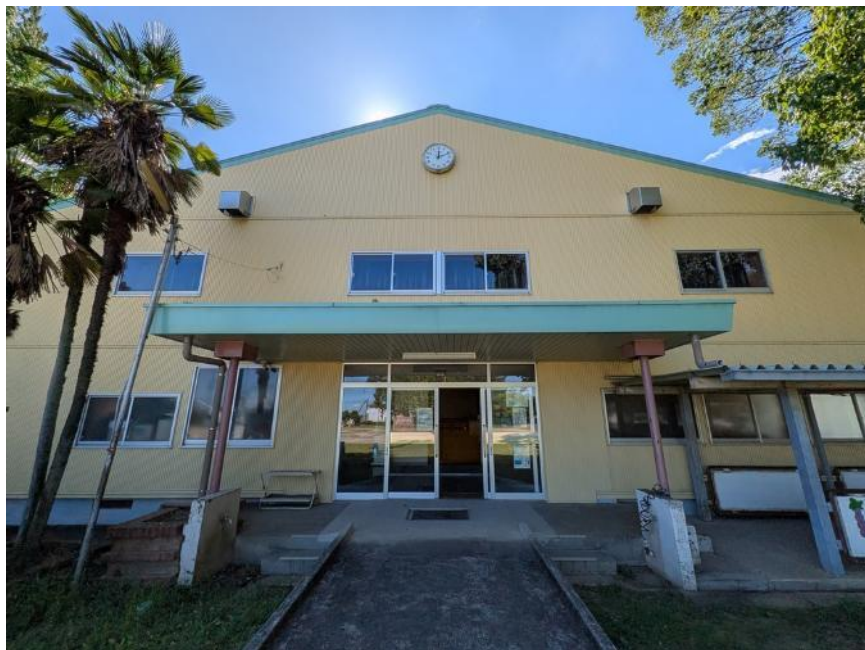
体育館の外観
