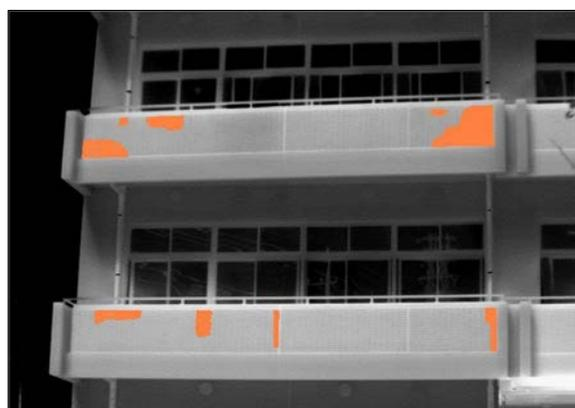
独自のデータ解析システムにより、外壁上のひび割れと浮き、剥離等の位置測定データをCAD立面図上に正確に転写し、ひび割れであれば幅と長さを、浮きであれば面積、タイル面に於いては枚数を自動集計します。
