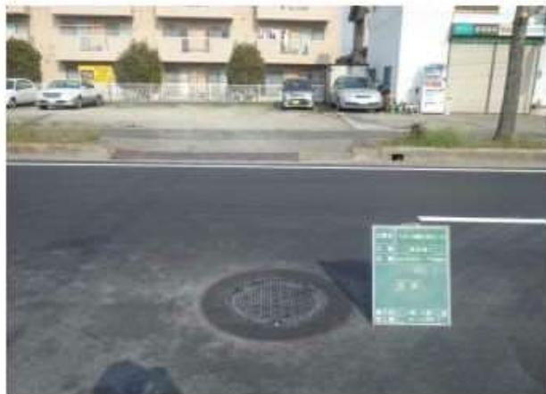
後処理工完成
