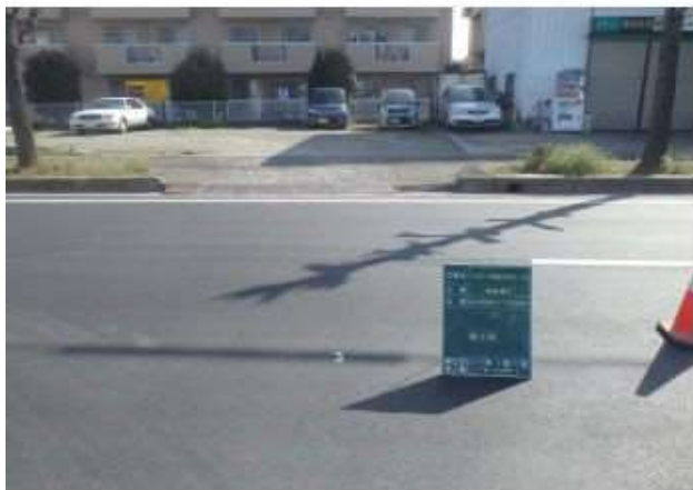
舗装工事後施工前
