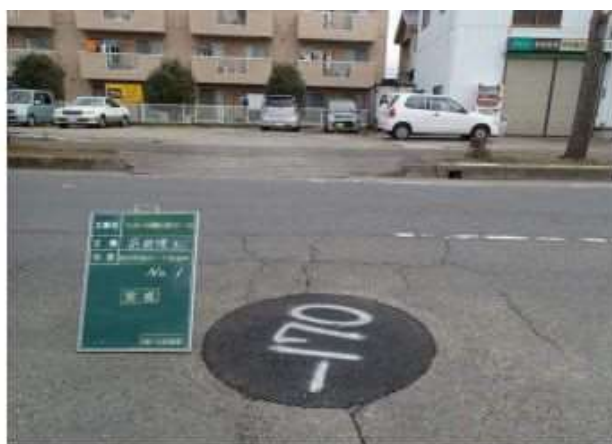
前処理工復旧完成
