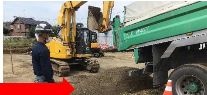
~20 mm調質改良土を埋戻し材として利用
