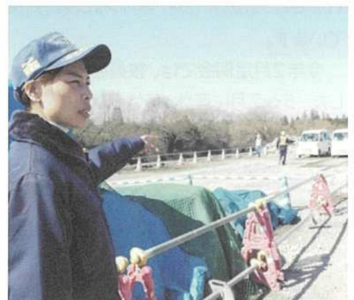
低水護岸整備の工事現場を視察する秋山もえ県議
