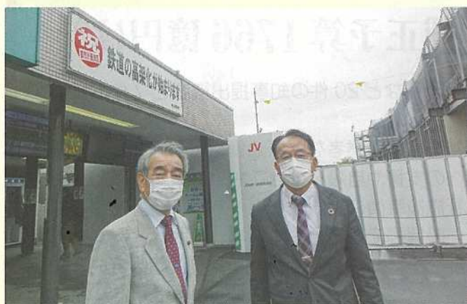
春日部駅仮駅舎工事の現場
