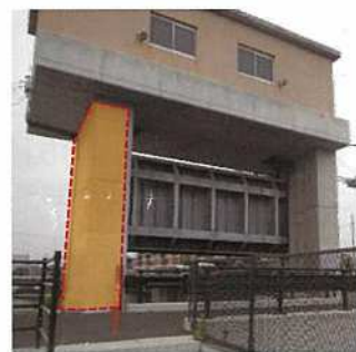
水門耐震補強の例(支柱の巻立補強)
