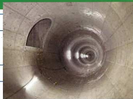
雨水貯留管の整備(川口市)
