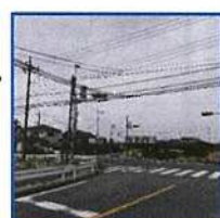
歩道工事が進む「小林交差点」
