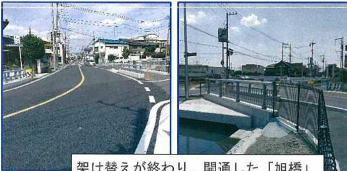
架け替えが終わり、開通した「旭橋」
