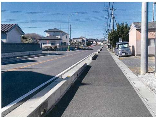
整備済み箇所：下横田地内
