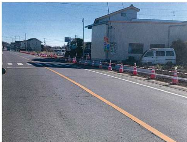
工事箇所：下横田地内
