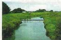
⑦上須戸堰地区
