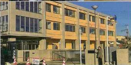
移転新築工事が進む熊谷児童相談所(令和5年4月開設予定)
