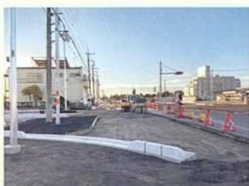
▲国道407号8Pから圏央鶴ヶ島IC方向撮影(埼玉県工事)
