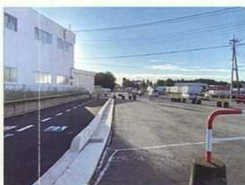
▲国道407号(圏央入口交差点から)圏央鶴ヶ島IC方向撮影(鶴ヶ島市工事)
