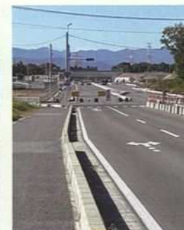
▲運動公園から圏央鶴ヶ島IC方向撮影(鶴ヶ島市及びNEXCO東日本工事)
