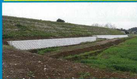
耐震補強工事が済んだ本堤（下流部）
