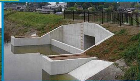
改修された洪水吐
