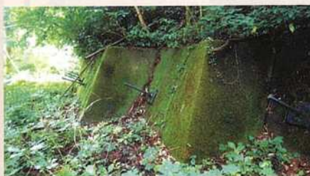
▲経年劣化のため抜けてしまったアンカーを、新たに打ち直します。
