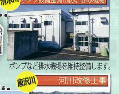
ポンプ設備整備(清水川排水機場)
