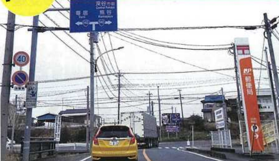
田中 立体交差バイパス道路(深谷・嵐山線)
