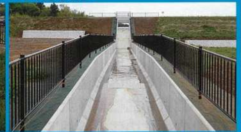
改修された洪水吐と下流水路
