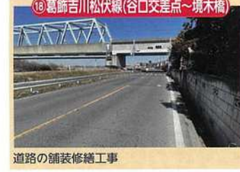
⑱ 境木橋 道路の舗装修繕工事
