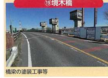
⑲ 境木橋 橋梁の塗装工事等
