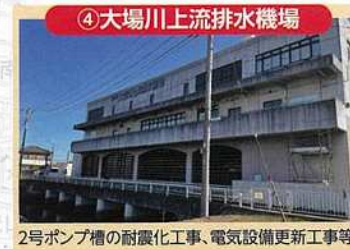
④ 大場川上流排水機場 2号ポンプ槽の耐震化工事、電気設備更新工事等
