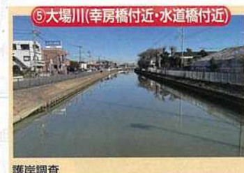
⑤ 大場川(幸房橋付近・水道橋付近) 護岸調査
