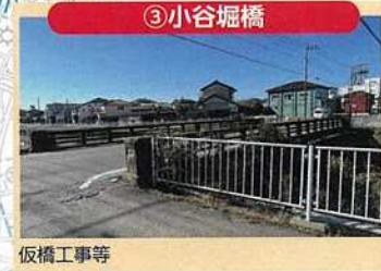
③ 小谷堀橋 仮橋工事等
