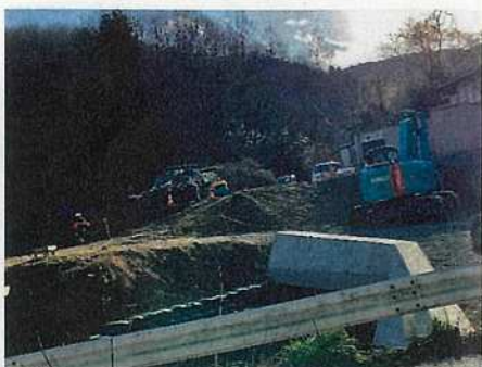
視距改良に伴う水路工事(太駄)
