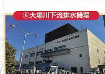
⑧ 大場川下流排水機場 2号ポンプ槽の耐震化工事、3号ポンプ槽の修繕のための設計等
