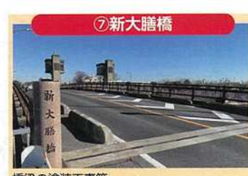
⑦ 新大膳橋 橋梁の塗装工事等
