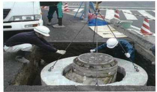
マンホールの耐震化施工例(ハットリング工法)
