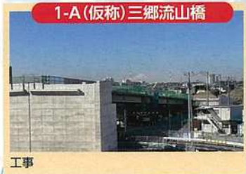
1-A(仮称)三郷流山橋 工事
