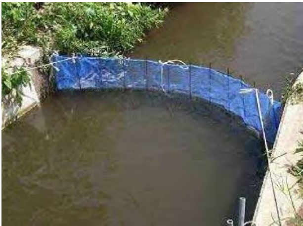
流出防止を目的とした網の設置例
