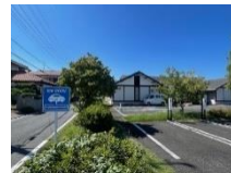
【公共施設のEV充電施設】
