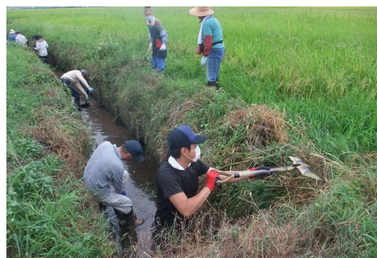
水路の泥上げ
