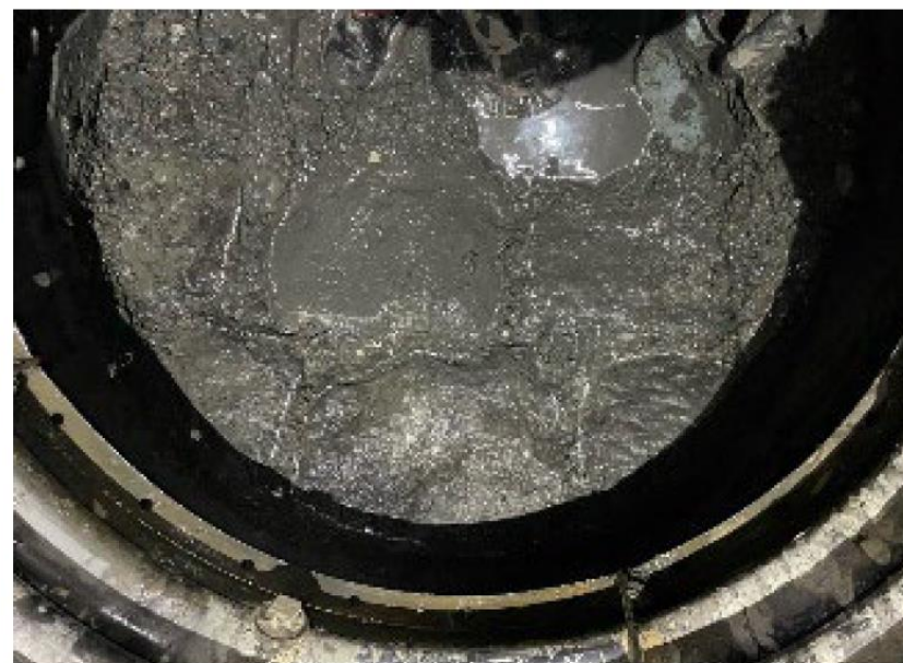
確認箇所②の状況(上面から撮影)
