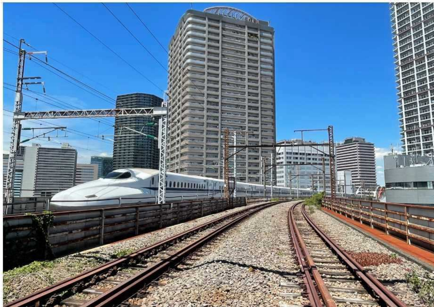
大汐線改修区間の現状
