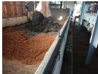
脱水土混合状況
