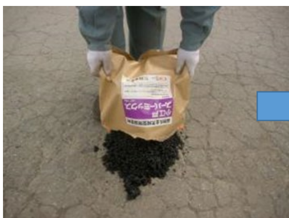
① 袋から出し敷きならす
