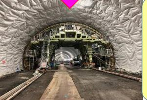
拡幅断面部へ 到達後、セン トルを広げて、 一部解体した 箇所もまた組 立をします。
