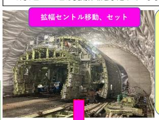
標準断面部が 通過できるよ うにセントル を一部解体し、 縮めて移動し ています。
