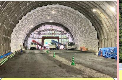
終点側(落合地区側)の坑口付近の大断面箇所へシート張り 台車を設置し、防水シートの設置を始めました。
